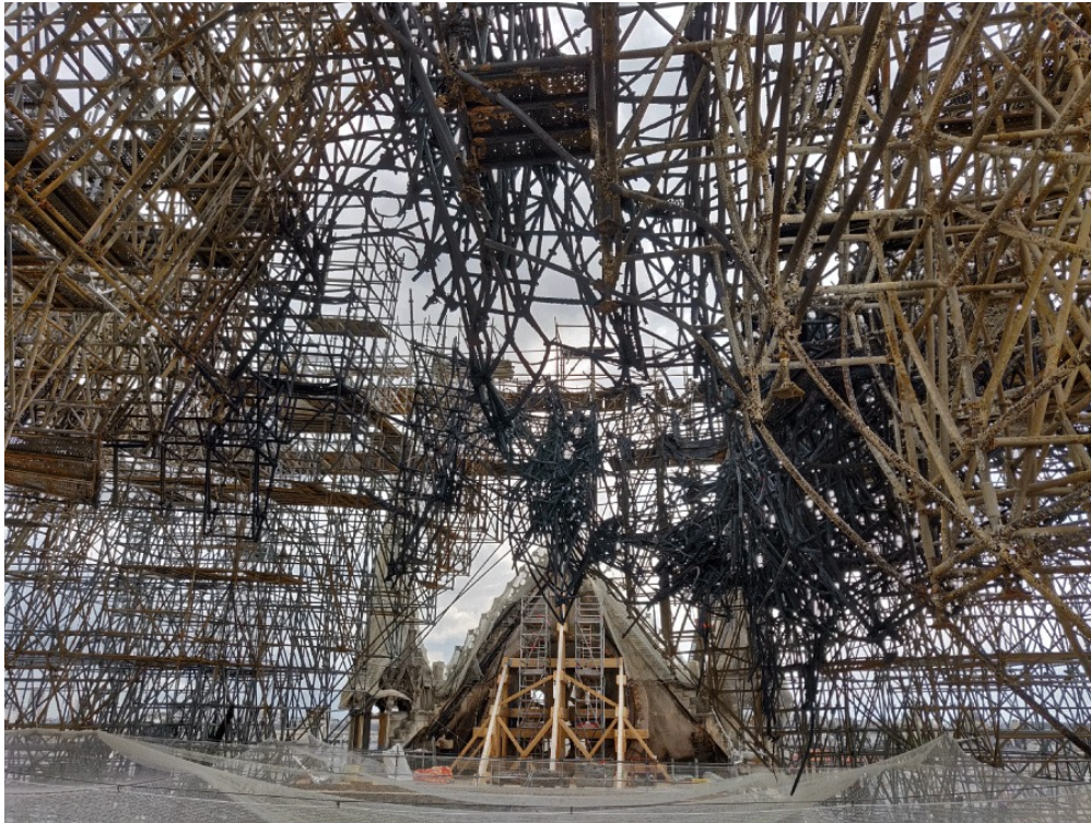
Figure 11. Échafaudages en acier (entourant la flèche avant l'incendie) déformés par les températures élevées (photo de Damien Deldicque et Jean-Noël Rouzaud).
